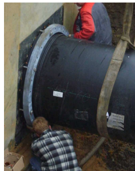
Montage der Anschlussleitung
