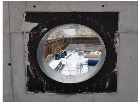
Dichtfläche säubern und Schutzstopfen entfernen
