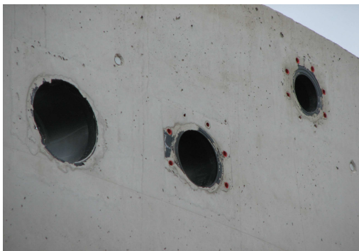
...nach Entfernen der Schalung
